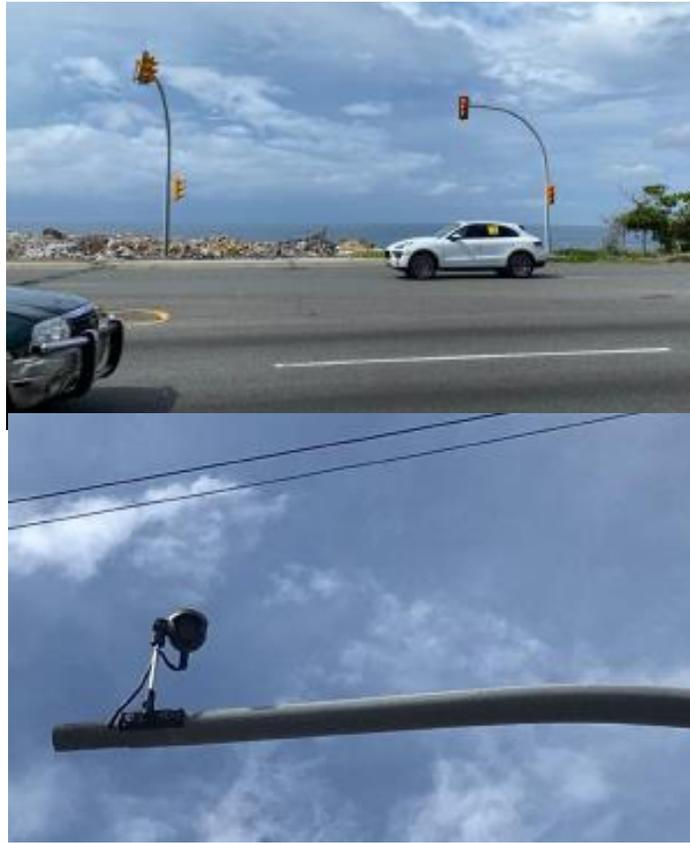
2. Cámaras de detección de vehículos que funcionan como sensores no intrusivos y que permiten gestionar los tiempos de verde de manera automática de acuerdo a la longitud de cola de la vía secundaria.
