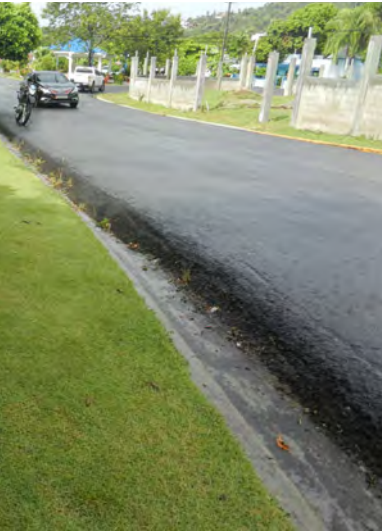
Imagen I. 11. Contén y acumulación de capas asfálticas en Samaná
