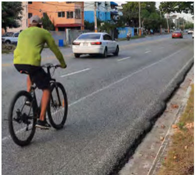
Imagen IV. 28. Contén junto a vía ciclista señalizada
