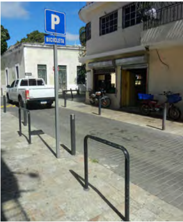
Imagen IV. 68. Estacionamiento con soportes de U invertida simples orientados longitudinalmente en Santo Domingo
