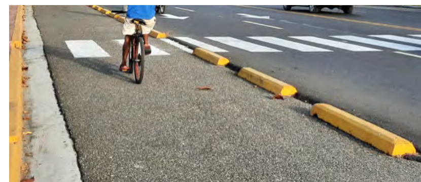
Imagen IV. 24. Pavimento bituminoso en ciclovía en Santo Domingo
