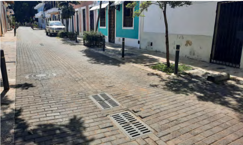
Imagen IV. 33. Drenaje central en calle adoquinada
