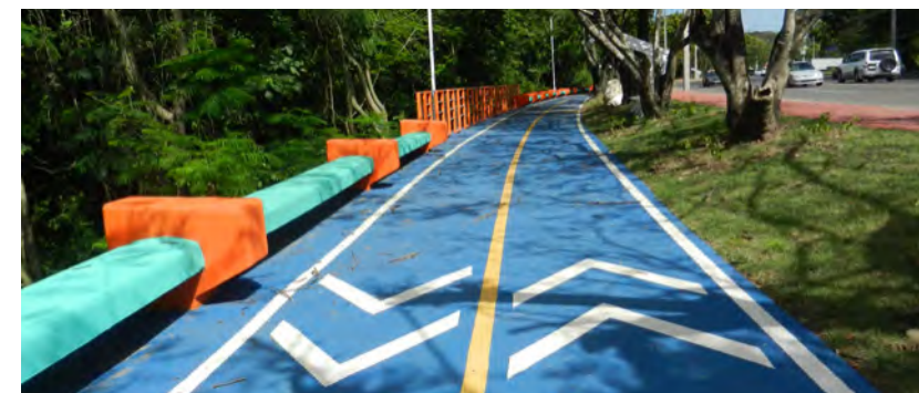
Imagen IV. 60. Vallas de hormigón y metálica de delimitación de la ciclovía en Santiago de los Caballeros
