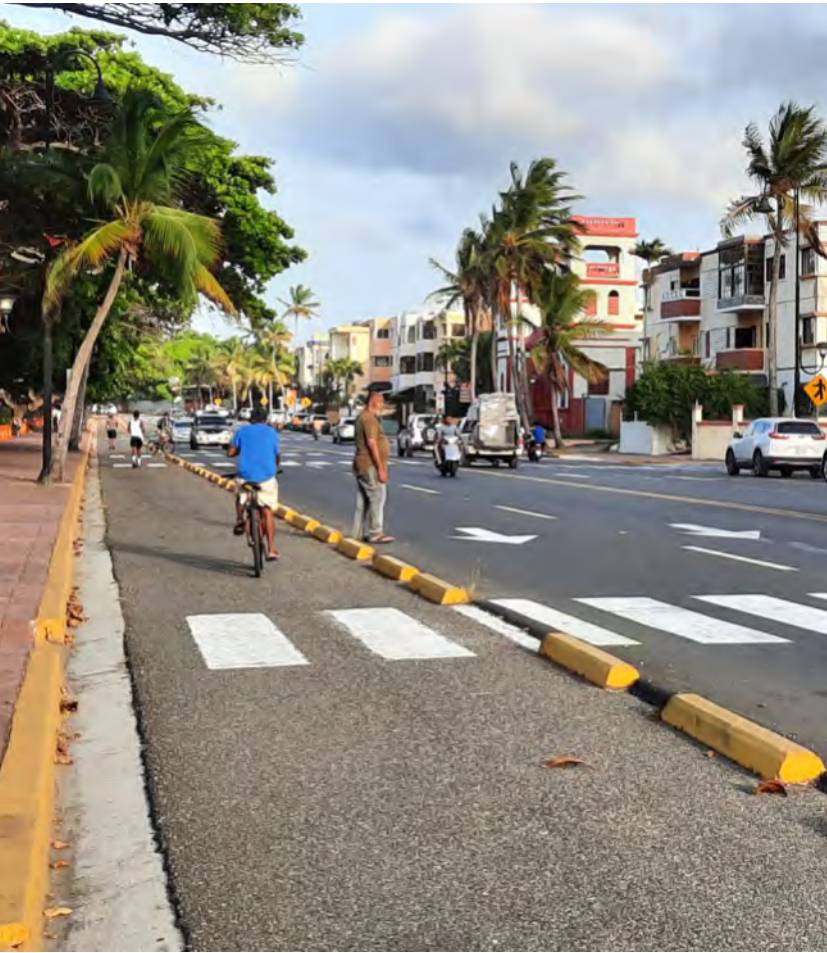
Imagen III. 24. Ciclovía segregada en Puerto Plata
