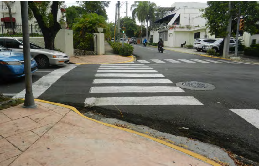
Imagen I. 10. Contén y acumulación de capas asfálticas en Santo Domingo
