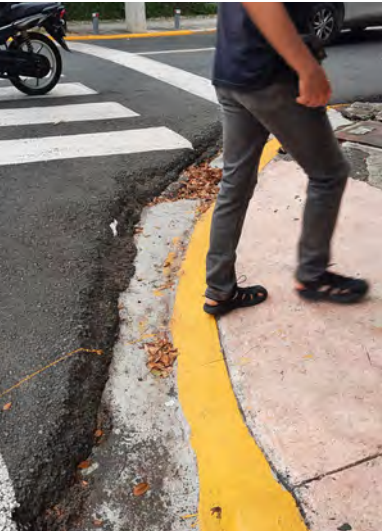
Imagen IV. 30. Encuentro del contén con el paso peatonal
