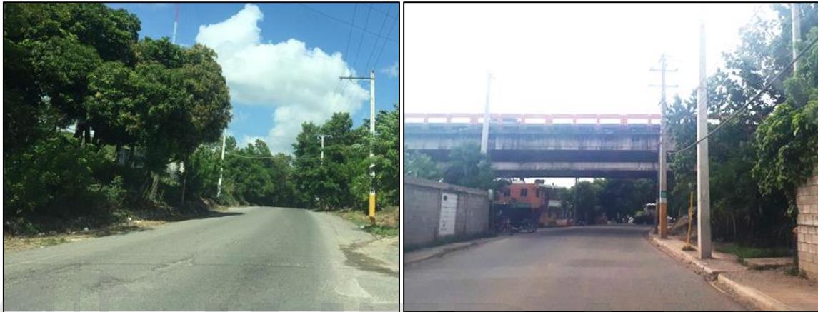
Figura 2: Señalización horizontal deficiente.
