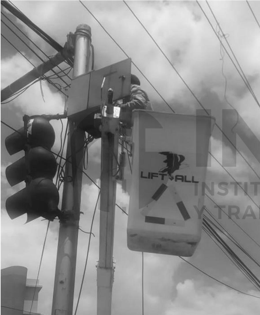
El *mantenimiento correctivo* puede definirse como el conjunto de tareas que se llevan a cabo para corregir los defectos observados en los equipamientos o instalaciones que afectan su correcto funcionamiento.
