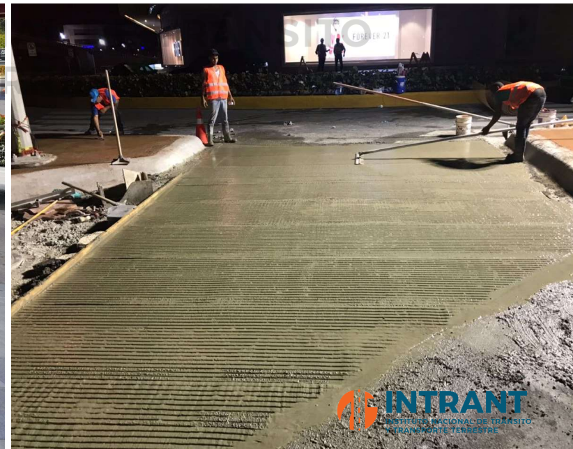
CONSTRUCCIÓN DE RAMPAS CON ACCESIBILIDAD UNIVERSAL
