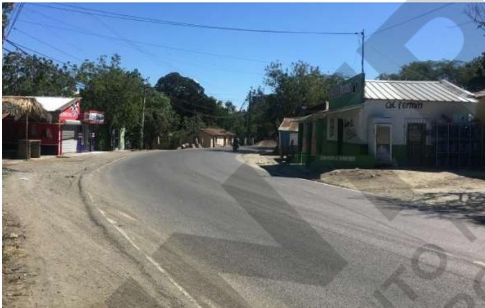
En esta fuerte Curva se observa que la señalización horizontal presenta desgaste y no posee la señalización vertical correspondiente.
