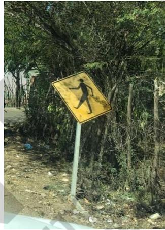
En el recorrido por la Carretera La Canela - Piedra Gorda se pueden observar algunas señales verticales deterioradas, con visibilidad obstruida por ramas de árboles y tubos doblados o chocados.
