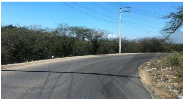
En estas imágenes se observan curvas fuertes y continuas, con una depresión por el lado izquierdo y una cuneta por el lado derecho, en sentido Este-Oeste, sin la señalización horizontal ni vertical correspondientes.
