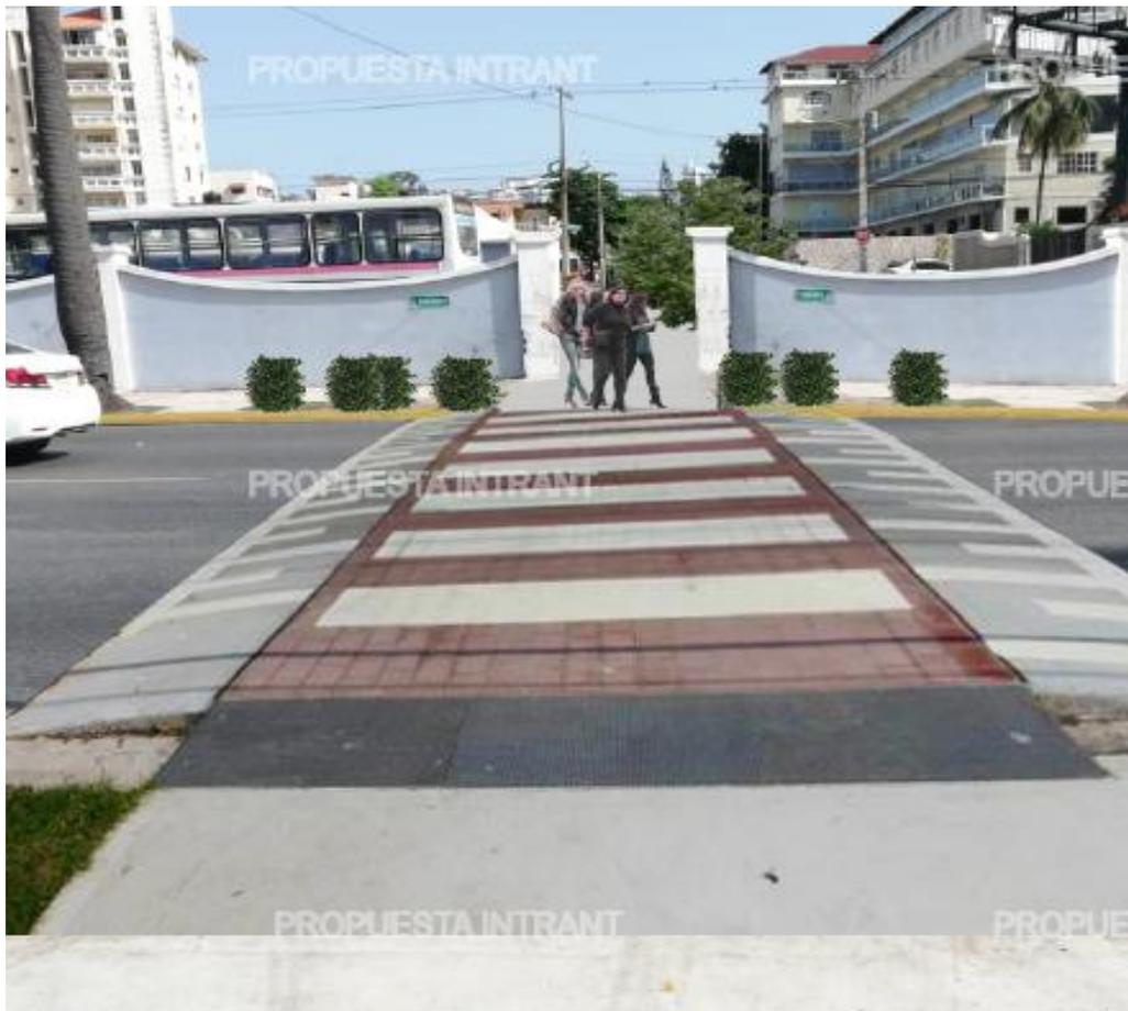
a) Ilustración 1. Propuesta Reductor de Velocidad (Speed Table)
