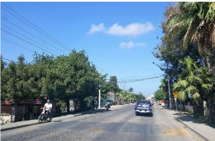
La Señalización Horizontal de los Reductores Tipo Lomo de Asfalto es deficiente, la pintura está regular en un 10%, desgastada en un 70% e inexistente en un 20 %.
