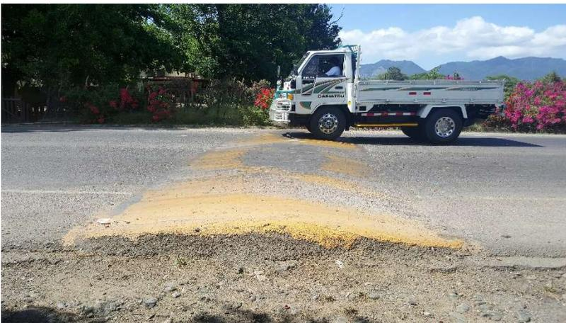
Las dimensiones de ancho y alto de los reductores de velocidad tipo Lomo son muy variables. El ancho varía desde 0.80 mts. hasta 3.30 mts. y la altura desde 0.08 mts. hasta 0.18 mts.
